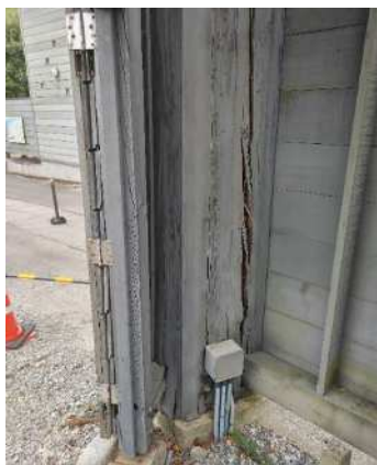
【ポンプ小屋の柱】
