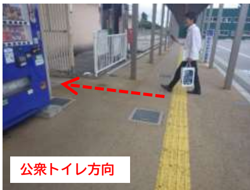
図【整備前】トイレまで誘導されていない視覚障害者誘導用ブロック
