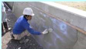
老朽化した水路壁のコーティング
