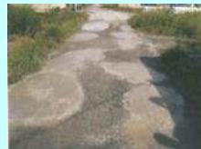
農道の窪みの補修
