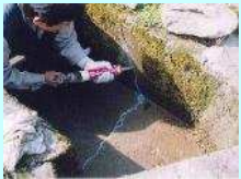
水路のひび割れ補修
