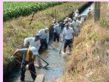
水路の泥上げ
