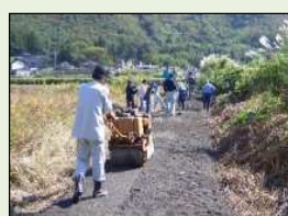
未舗装農道の舗装
