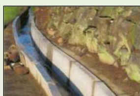
素堀り水路からの更新
