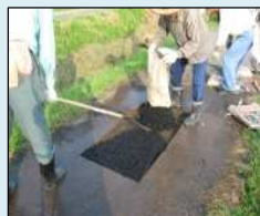
農道の部分補修
