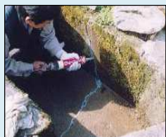
ひび割れの補修
