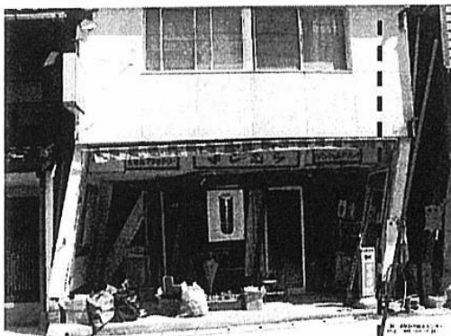
写真③-1 (傾き 3.8/20) [出典※1] (ランク 4)
