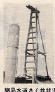
簡易水道さく井状況
