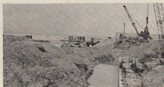
建設中入善漁港
