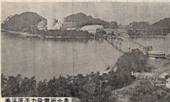
美浜原子力発電所全景
