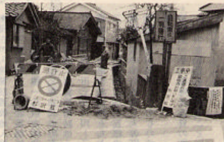
改修される流雪溝
