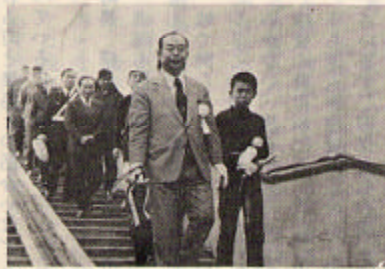
完成した8号線上原横断地下道
