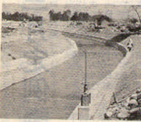
改修された用水
