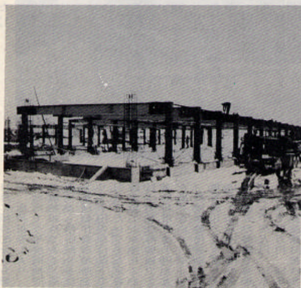
急ピッチで建設が進む 上青小学校
