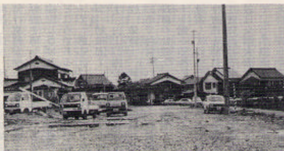
建設中の幹線(市街地東町)
