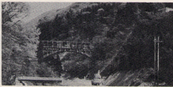
愛本発電所建設予定地（音沢地内）
