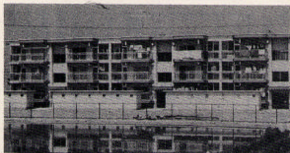
完成した駅南住宅
