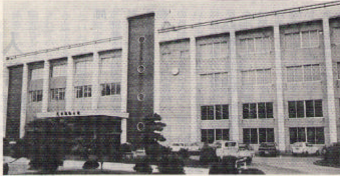
福祉会館前の駐車場
