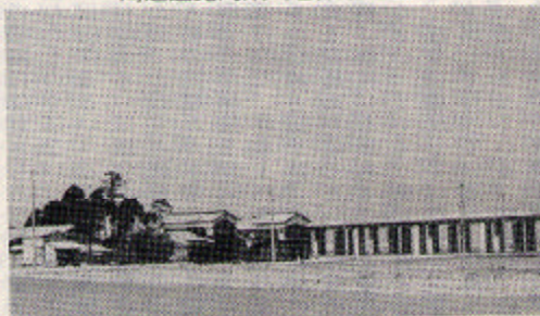
高速道路高架(若栗新地区)
