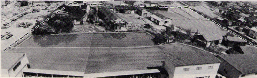
町民会館建設予定地(役場北側)
