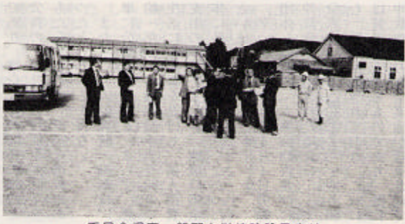
委員会視察 飯野小学校建設予定地
