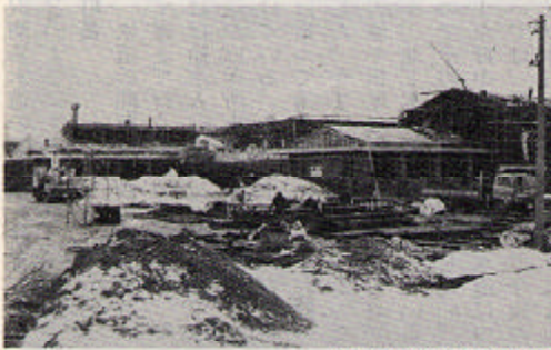
建設が進む飯野小学校
