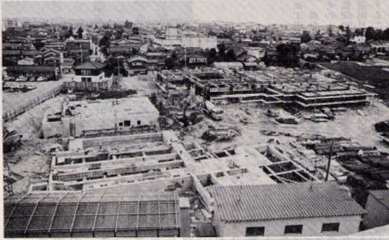
急ピッチに建設が進む町民会館
