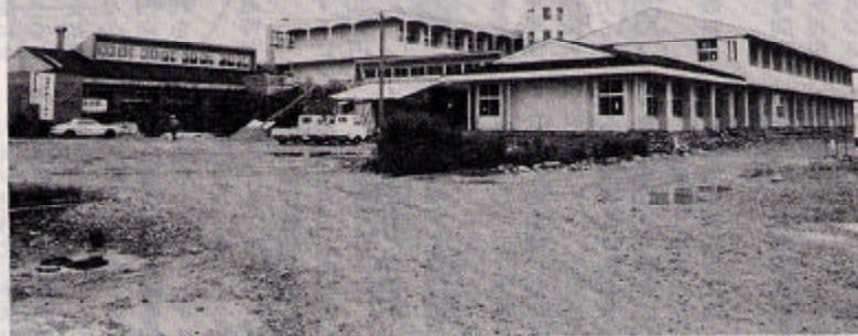
完成間近い飯野小学校
