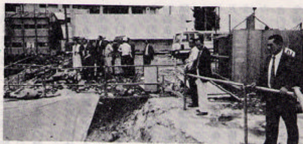
町民会館建設現場に於いて
