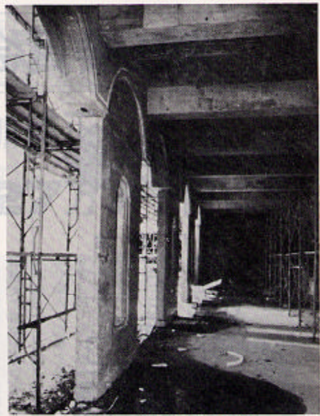
急ピッチに進む町民会館 (回廊部分)
