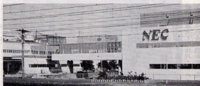
拡張なった富山日本電気
