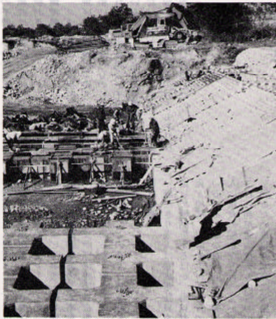
早期整備完了が望まれる護岸堤（上飯野堤）
