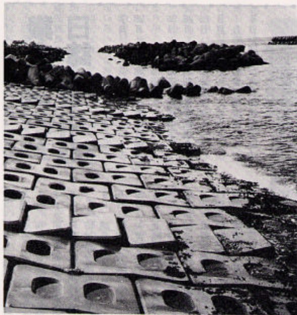
多目的に設置された緩傾斜堤 (朝日町赤川地内)
