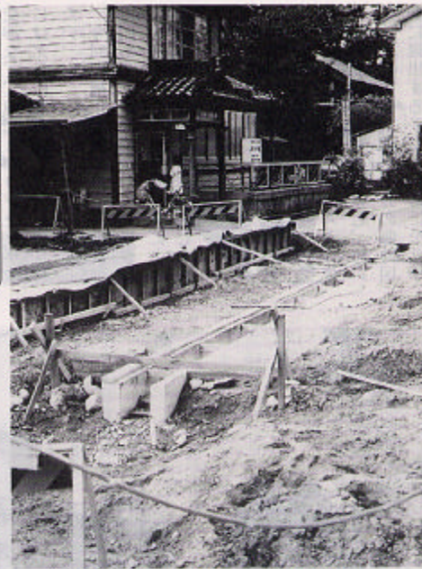
▲防火水槽工事現場 — 芦崎地内 —
