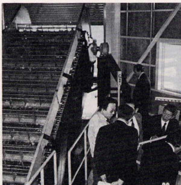
▲豪雪地帯の新井市でスノートピアを視察 (階段状のものは水と雪の分離装置)
