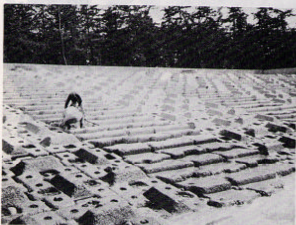
▲ 園家山キャンプ地前に設置された緩傾斜堤
