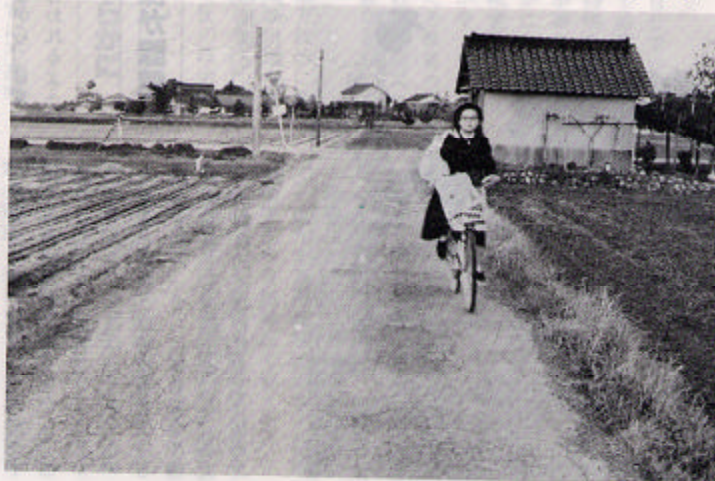
▶ 痛みが激しい簡易舗装道路
