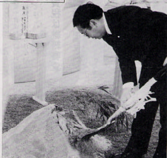
▲10月19日、屋内ゲートボール場の起工式
