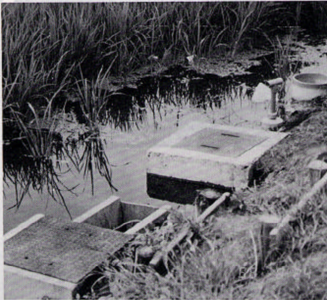
▲ 水田の用排水は地下パイプ
