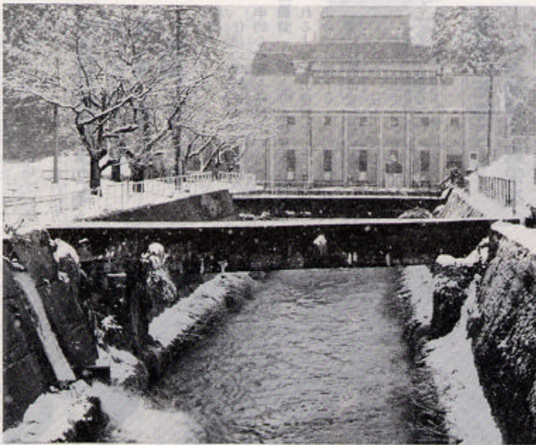
▲ 改修が間近い黒東合口用水と下山発電所
