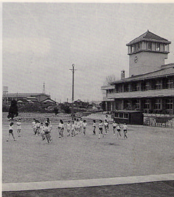
▲あとはグラウンド、体育館(入善小学校)
