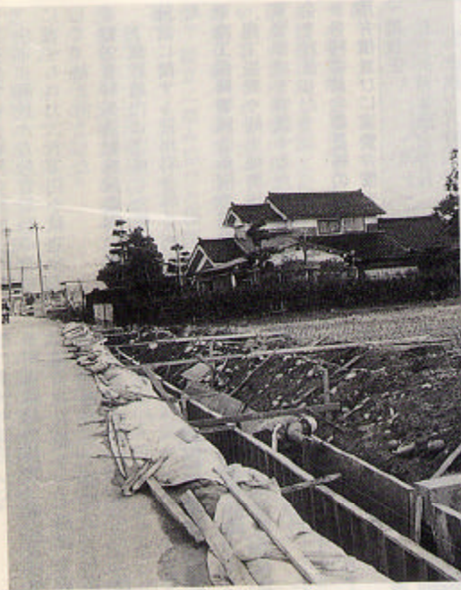
▲各地で進む水路改修（青木地内）
