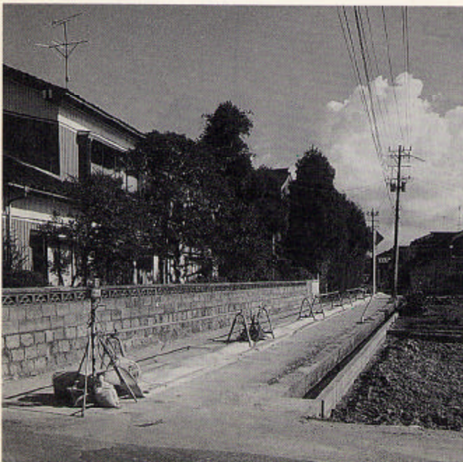
▲計画的に進められる消雪工事（笹原地内）
