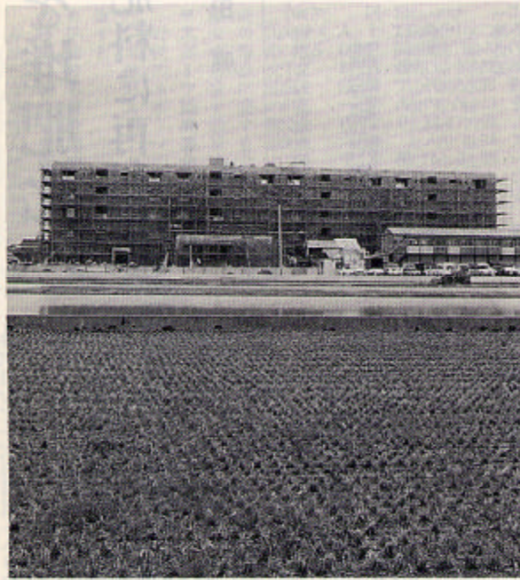
▲桐山地内で建設中の雇用促進住宅
