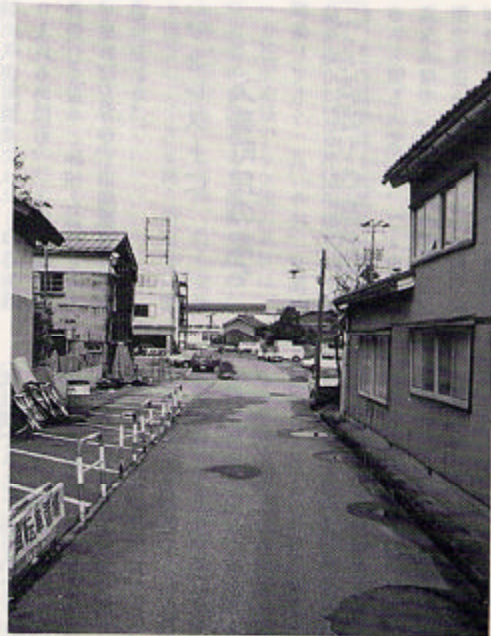
▲物件移転が進む中央通り線
