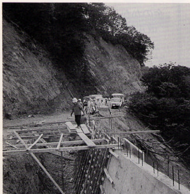
▲林道六谷線災害復旧工事（舟見地内）
