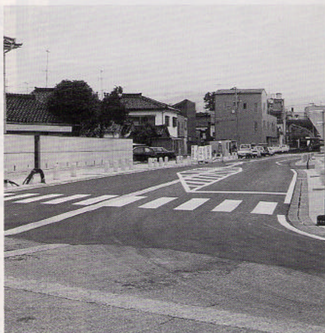
▲入善駅前から中町線まで一部供用される中央通り線
