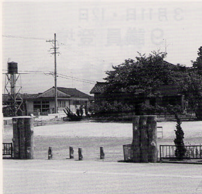
▲小摺戸地区コミュニティ施設建設予定地 (一宿地内・淡成公園)
