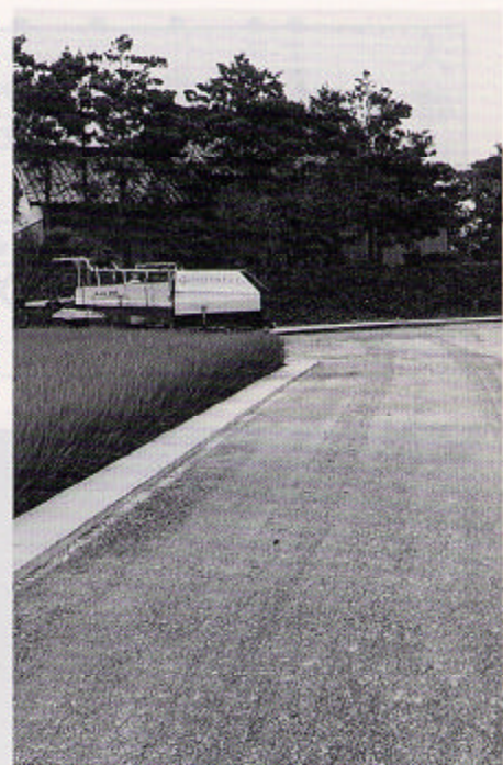
▲農村基盤整備事業で進む道路改良舗装(高瀬地内)
