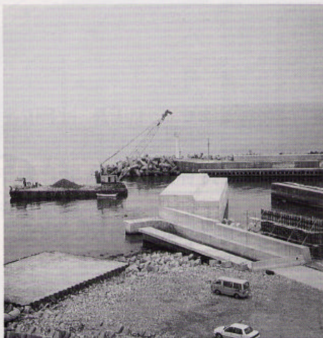
▲改良工事が進む西防波堤（入善漁港）
