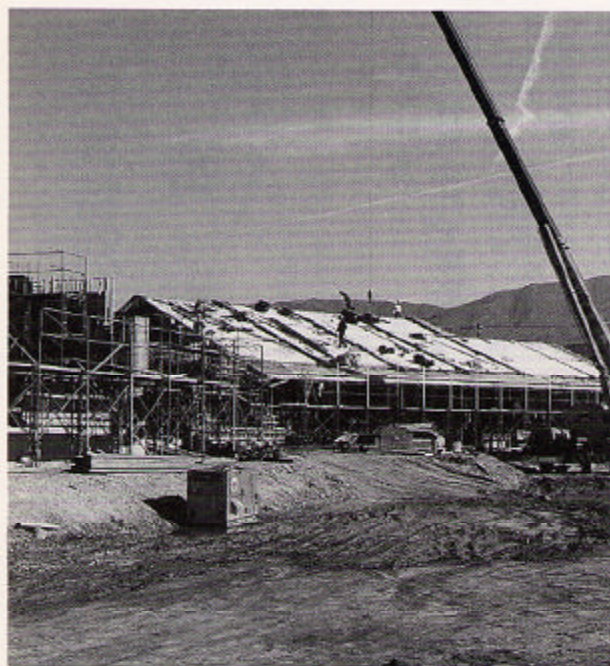
▲順調に進む校舎建設 (ひばり野小学校)
