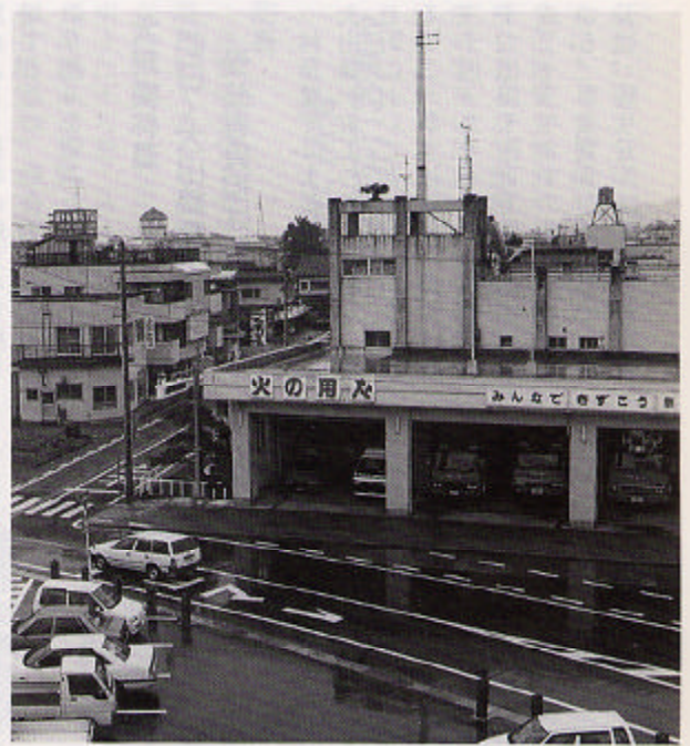
▲手狭になってきた消防庁舎 移転改築の検討を要望
