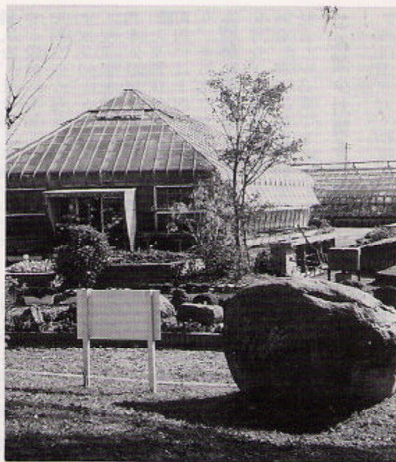
▲施設全体の見直しが必要 (フラワーセンター)
