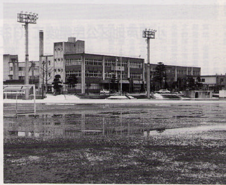
▲排水機能が低下し全面的な整備が求められる 西中学校グラウンド
