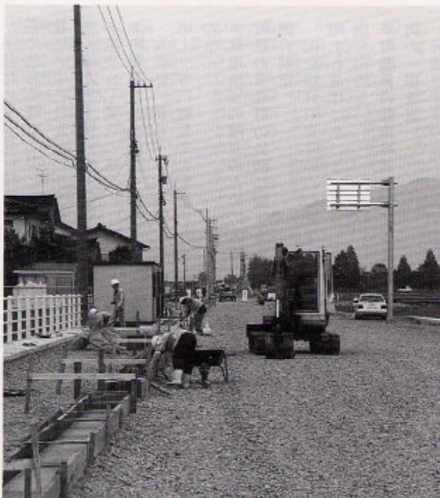
▲上田上飯野線の拡幅改良工事（上野地区）
