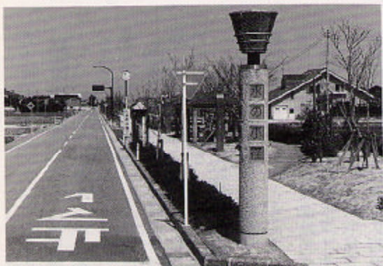
▲完成した水の小径
