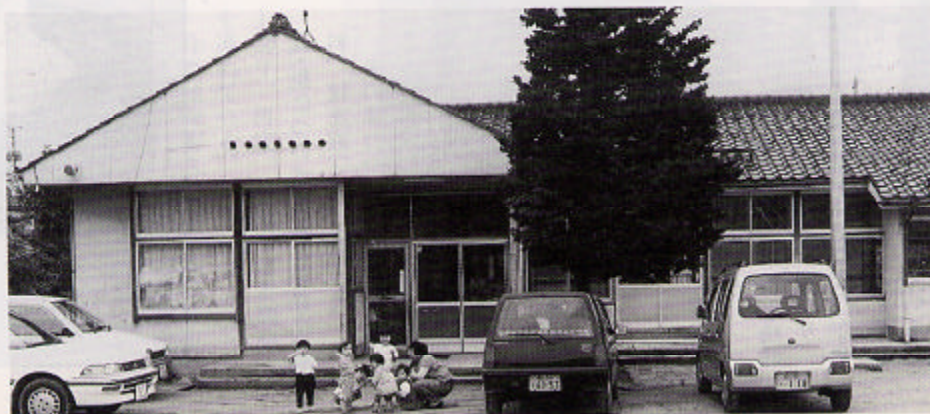
▲すずらん教室に改装される旧東部保育所
