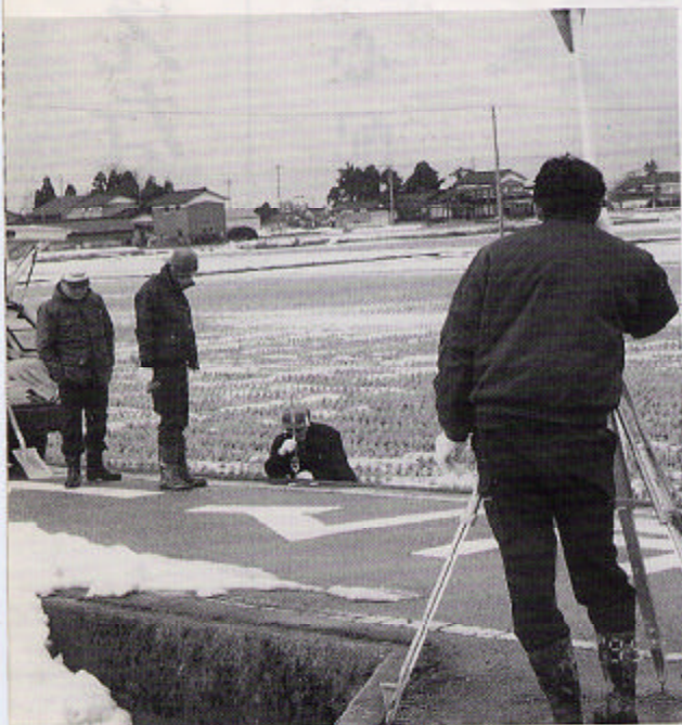
▲新幹線を中心測量（新屋地内）
