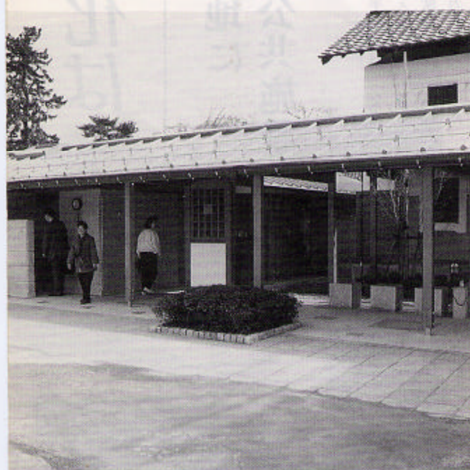
▲中央通り線の施設公衆トイレ
