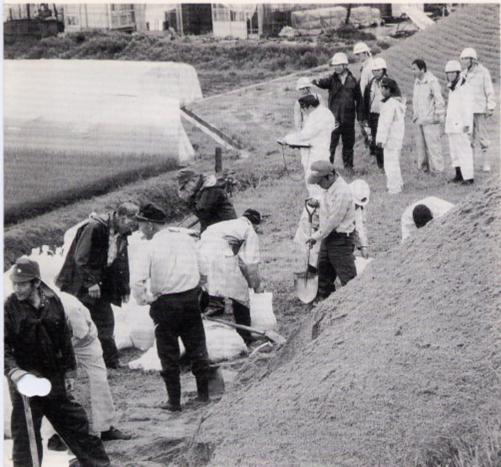
▲ 漏水をくいとめる「月の輪工法」（板屋地内）
