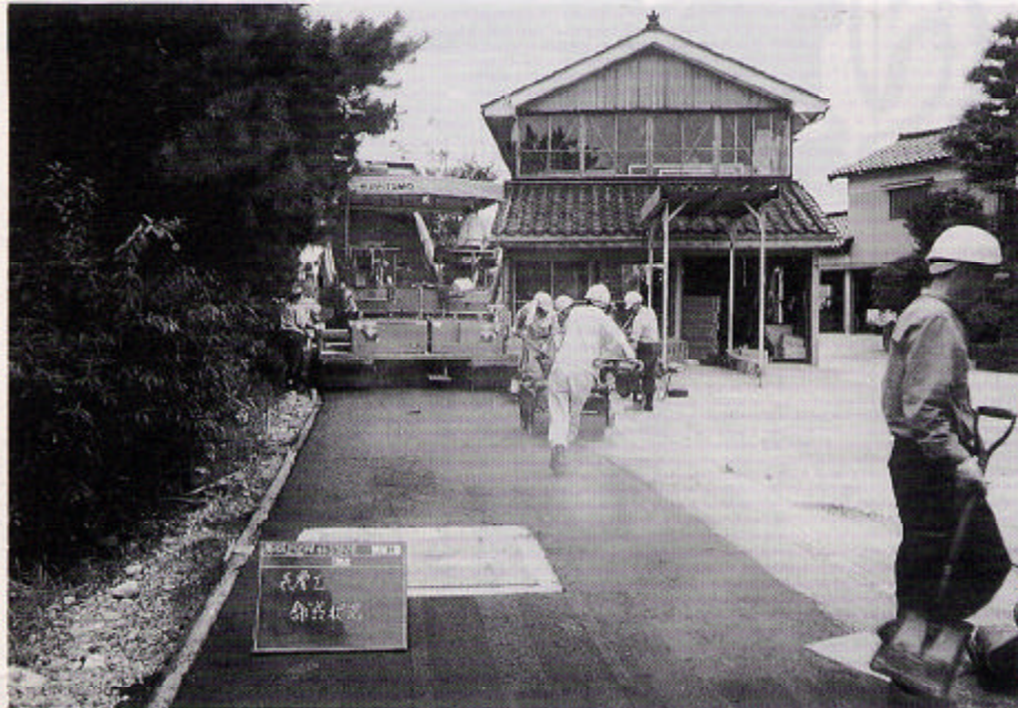
▲舗装が進む町道
