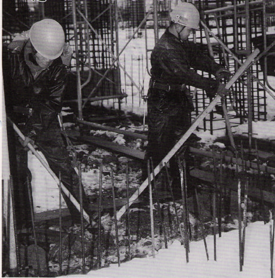
▲ 建設進む桃李小学校
