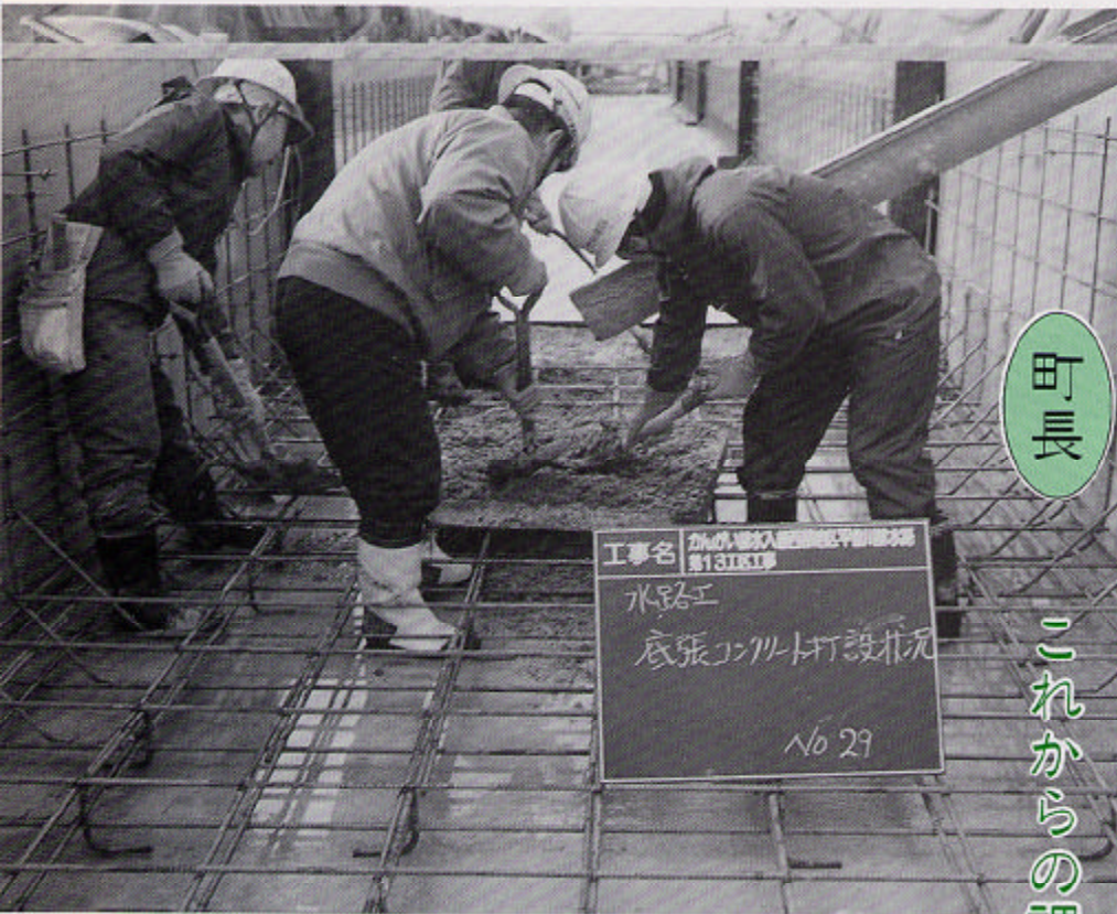
▲ 自然にさからう、コンクリート河川
