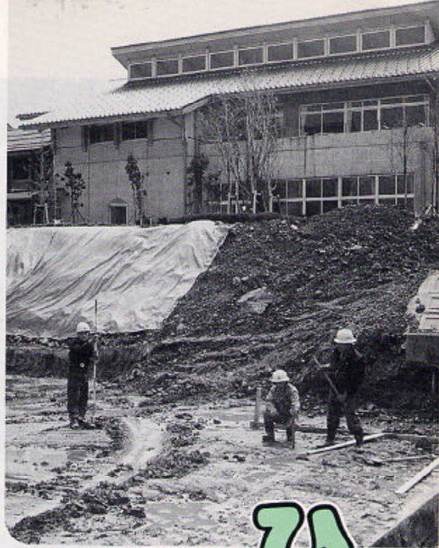
プール建設現場
