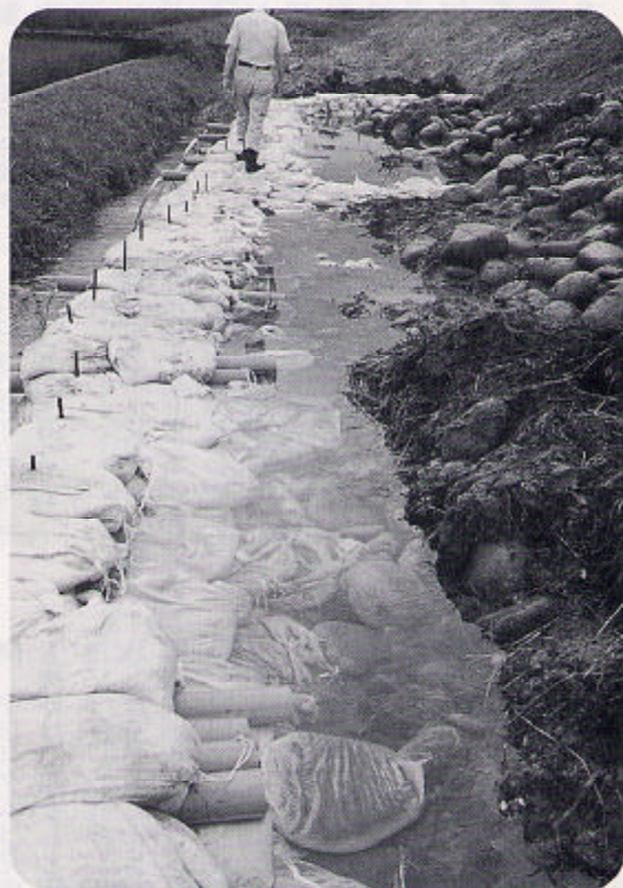
月の輪工法による災害復旧
