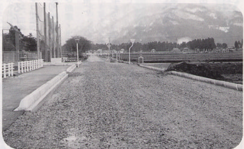
着々と進む道路整備
