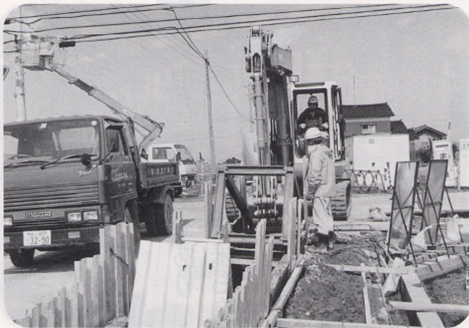
進む下水道工事
