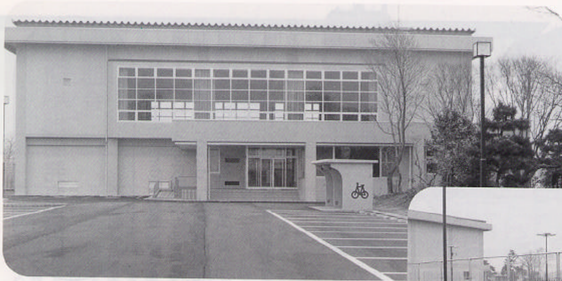
完成した「サン・ビレッジ入善」 (横山地内)
