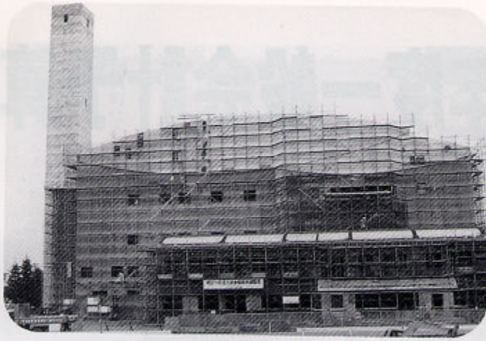
建設中のゴミ処理施設
