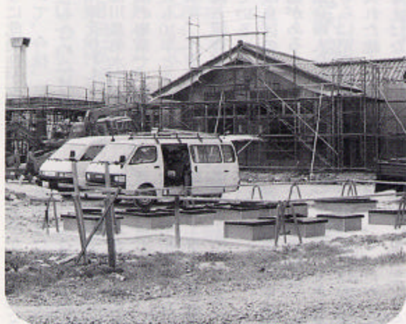
重度棟建設現場
