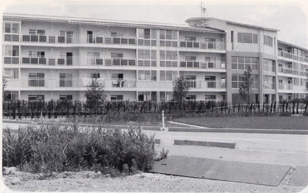
太陽光発電導入住宅（黒部市）
