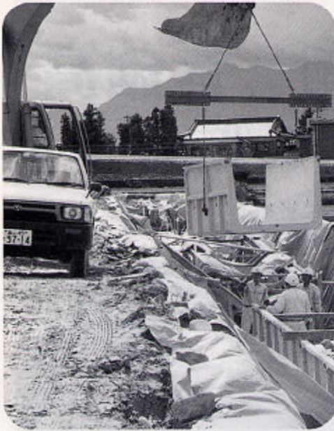
工事中の用排水路（下上野地内）
