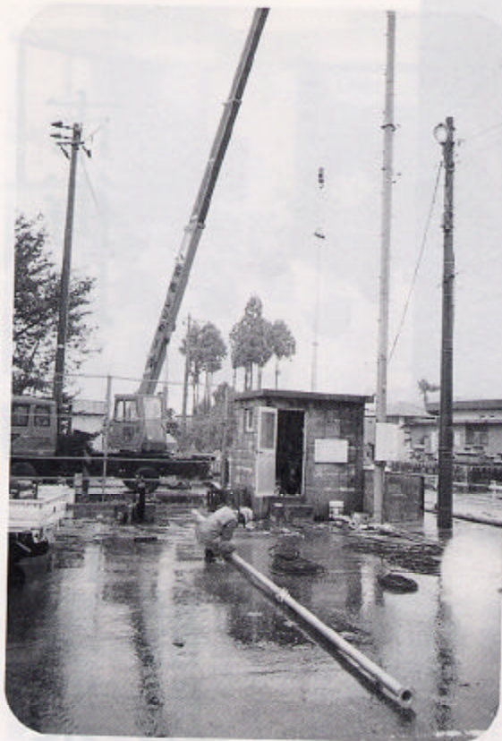
水源地のポンプ取替工事（舟見地内）
