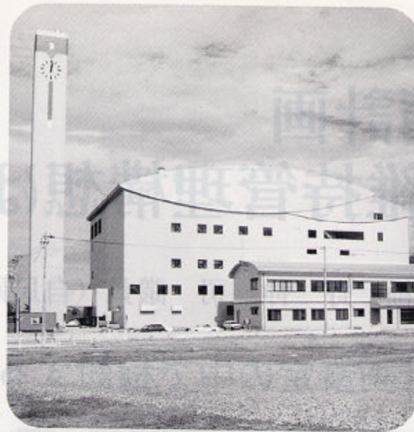
稼動間近の新焼却炉
