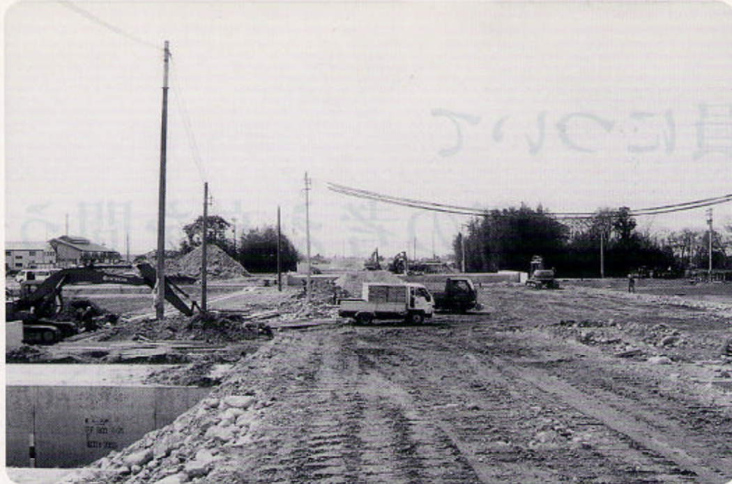
工事が進む国道8号バイパス
