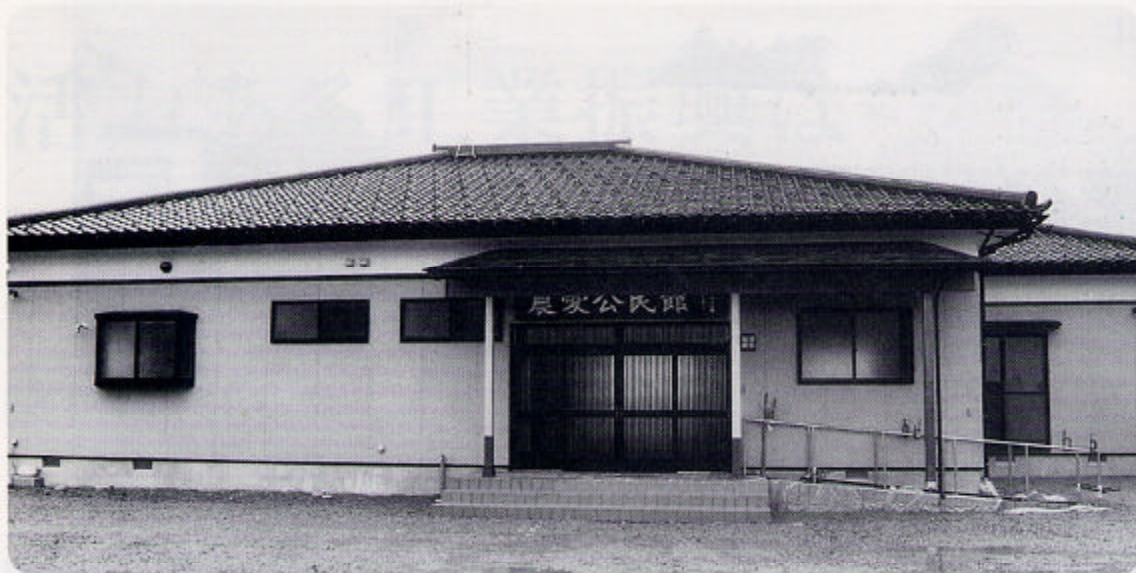
完成した農愛地区公民館
