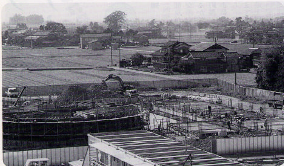
工事が進むふれあい交流プラザ (仮称)
