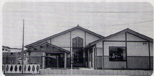
改築中の芦崎保育所
