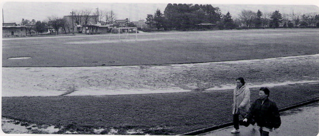
改修が待たれる陸上競技場
