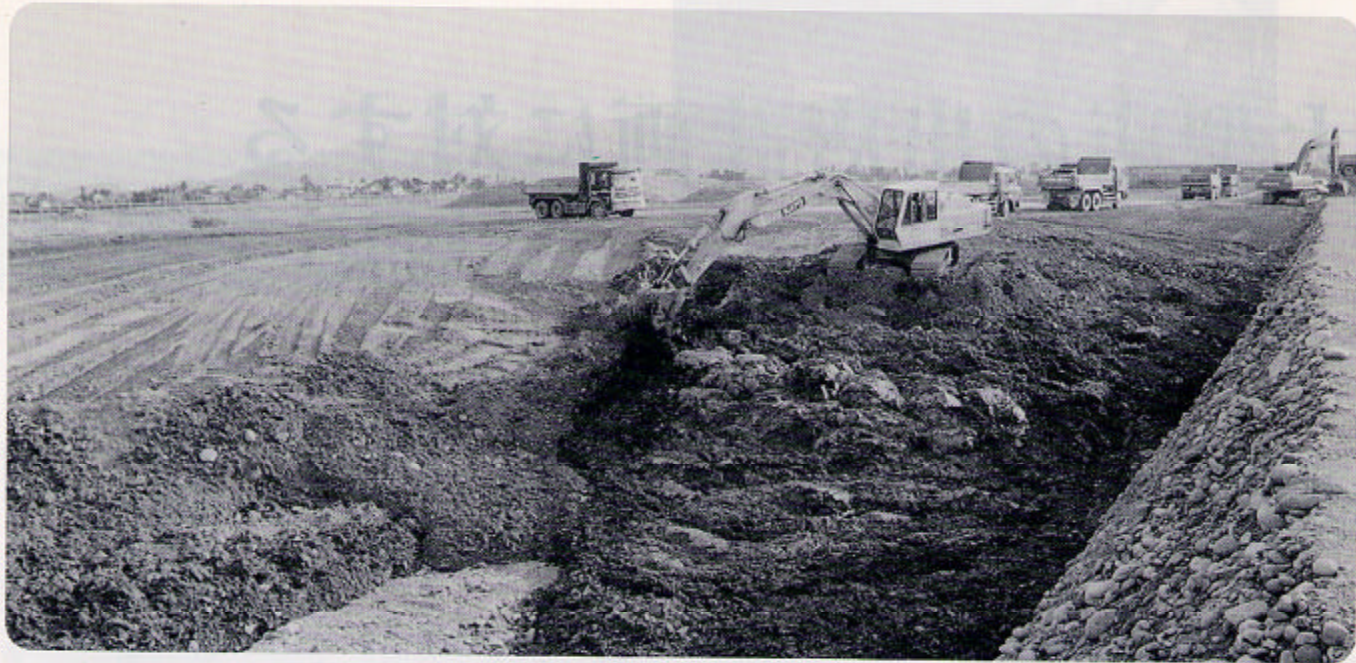
陸砂利採取後の埋め戻し作業
