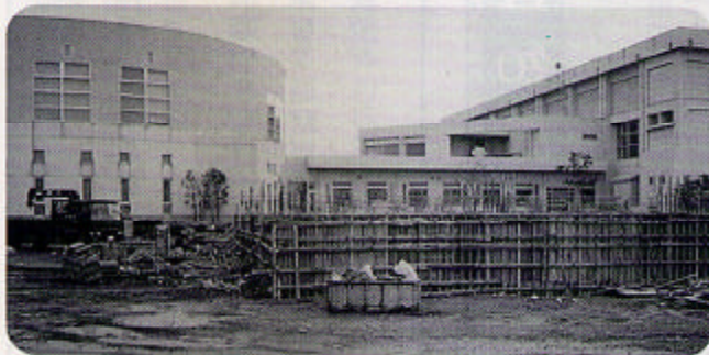
総合体育館の隣で建設がすすむ鐘成館
