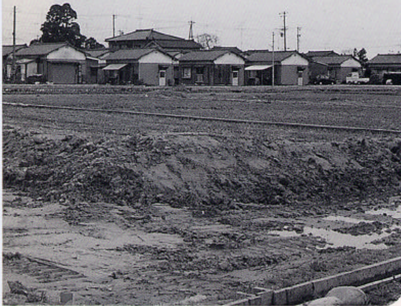
東町住宅と建設用地
