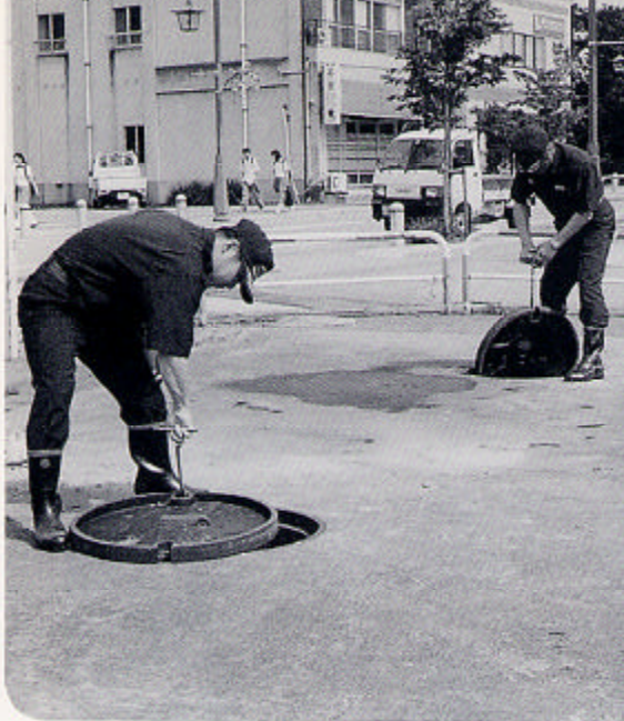
市街地の防火水槽点検
