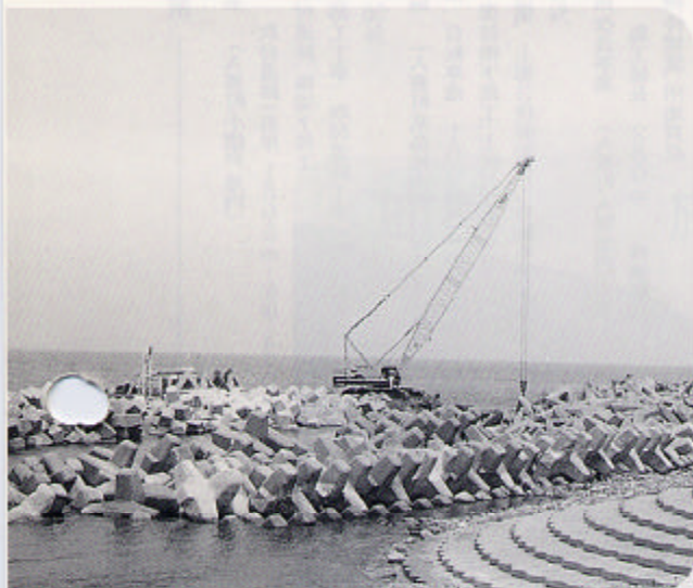
海岸保全整備工事
