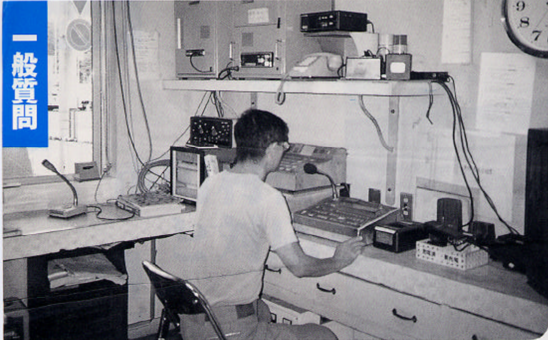
改善がのぞまれる防災・救急指令室
