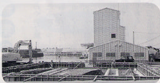
入善漁港蓄養施設建設工事
