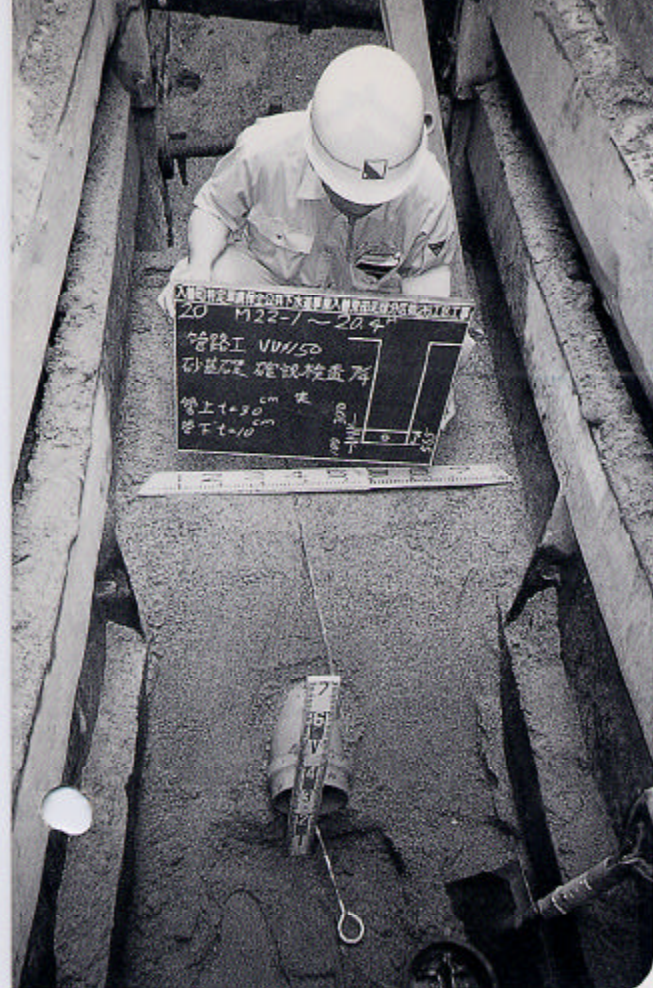
優良工事と評価された下水道工事
